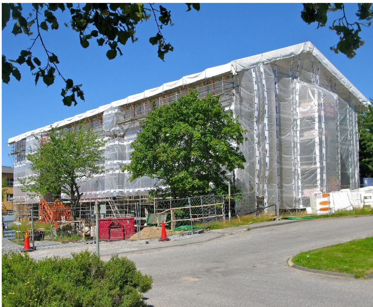
Ombyggnad till passivhus under väderskydd (AB Alingsåshems ombyggnad av hus från miljonprogrammet i Brogården)
