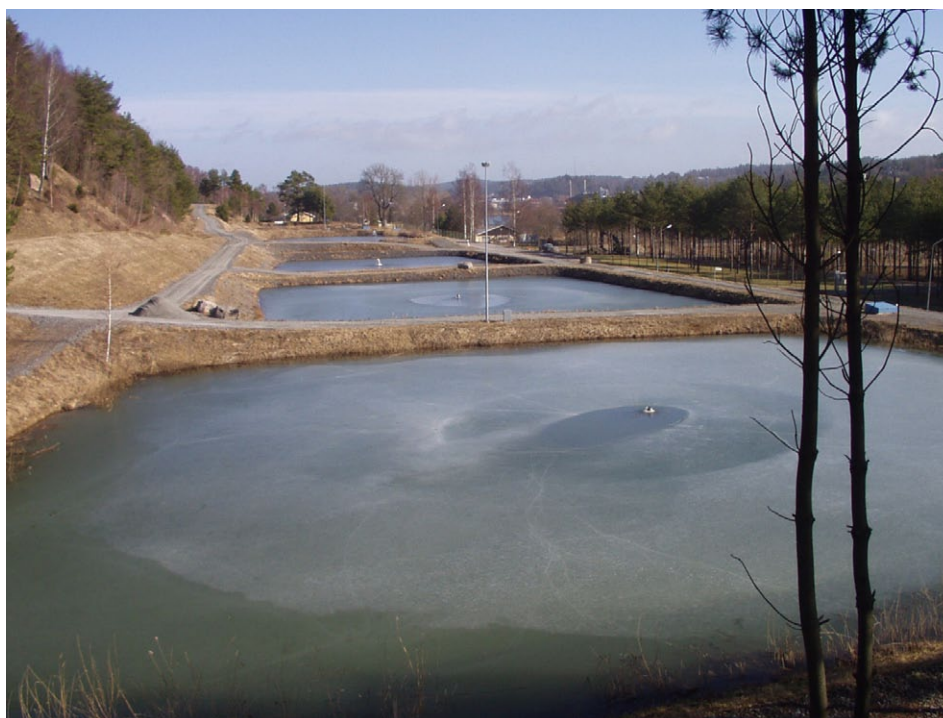
Infiltrationsdammar vid Dösebacka, Kungälv's huvudvattentäkt. Foto Måns Lundh.
