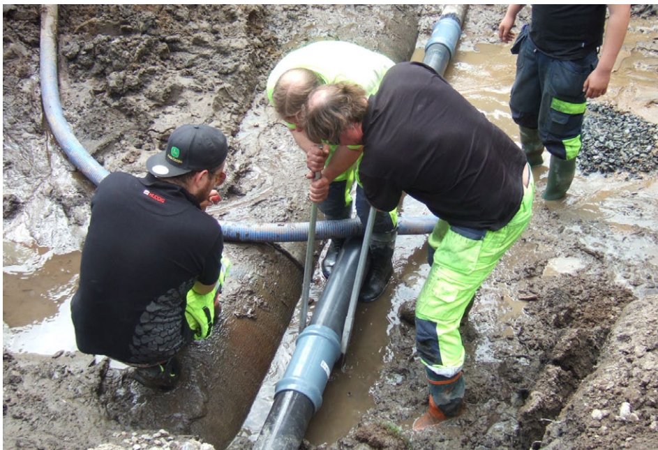
Lagnig av vattenläcka, Landvetter. Foto Härryda kommun.
